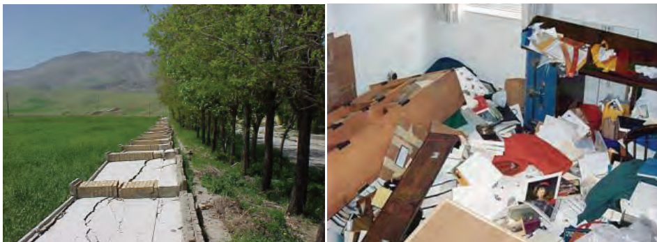
تصویر ۹-۱- واژگون شدن اسباب و اثاثیه در اثر زلزله تصویر ۹-۲- واژگون شدن دیوار - زلزله ۱۳۸۴ لرستان
