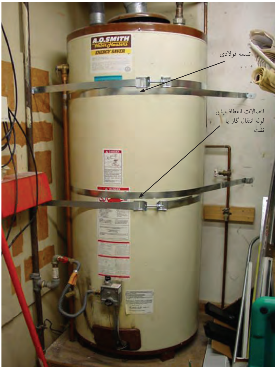
تصویر ۹-۵- نمونه‌ای از نحوه مقاوم‌سازی آبگرمکن
