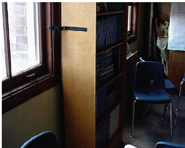
تصویر ۹-۸- تعبیه بست برای جلوگیری از واژگونی کمد در اثر حرکات زمین‌لرزه
