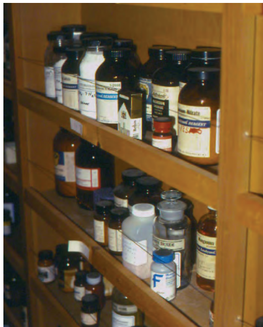
تصویر ۹-۶- نمونه‌ای از نحوه مقاوم‌سازی قفسه‌ها
